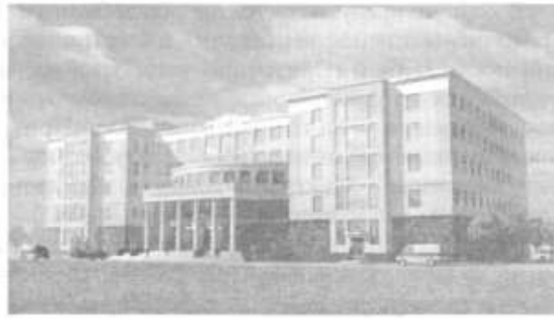
Рисунок Н.1 - Фасад здания
